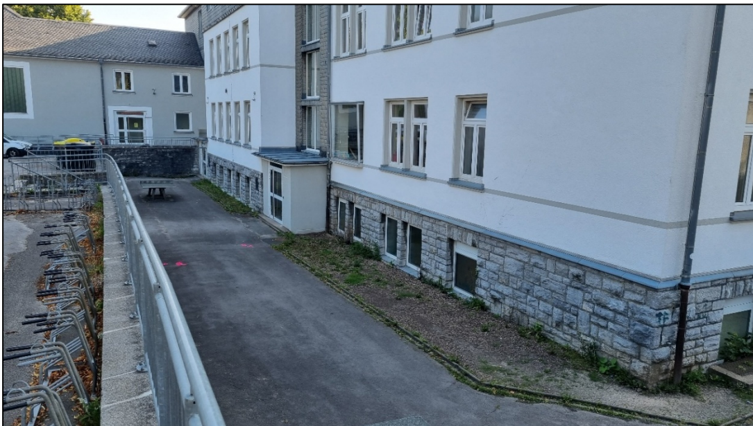
Foto 3: Situation am Eingangsbereich des Hauptgebäudes
