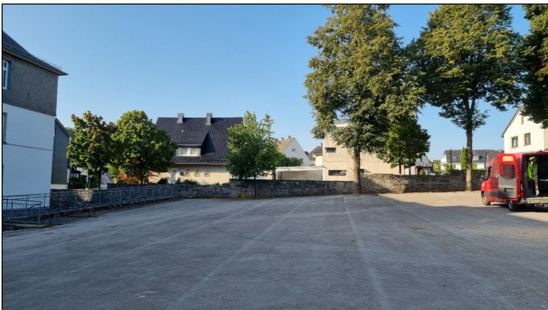
Foto 2: Baufeld, Blickrichtung Südwest
