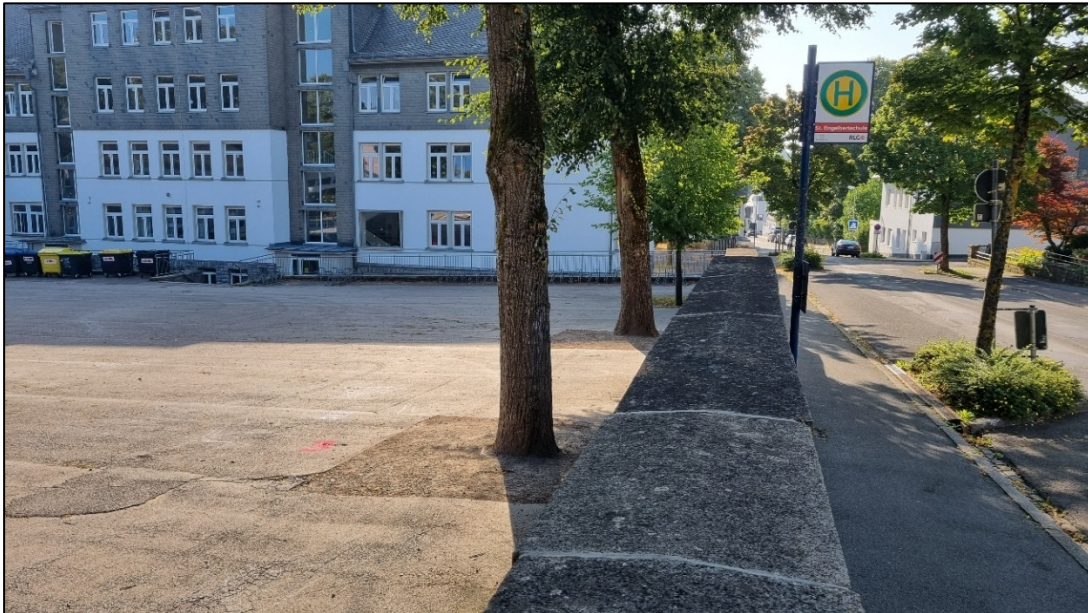
Foto 5: Grenzsituation Bereich asphaltierter Pausenhof
