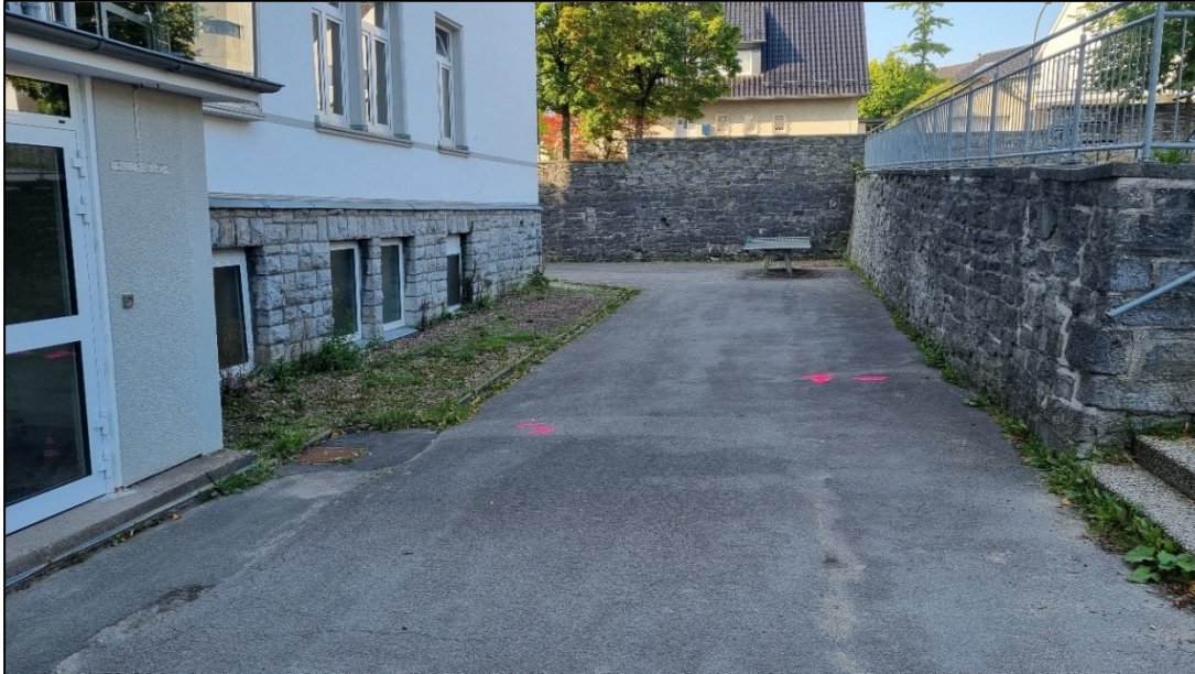
Foto 4: Stützmauer zwischen Eingangsbereich und Schulhof
